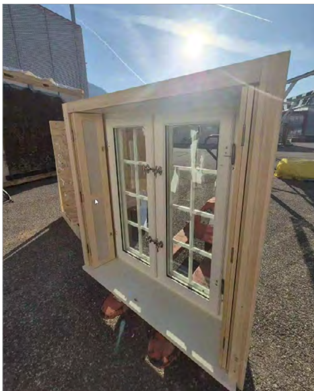
Figure 63 : Le vitrage de la fenêtre intérieure de cette double fenêtre historique a été remplacé par du double-vitrage sous-vide. Les performances thermiques de la double fenêtre ainsi rénovée se rapprochent de celle d'une fenêtre neuve.
