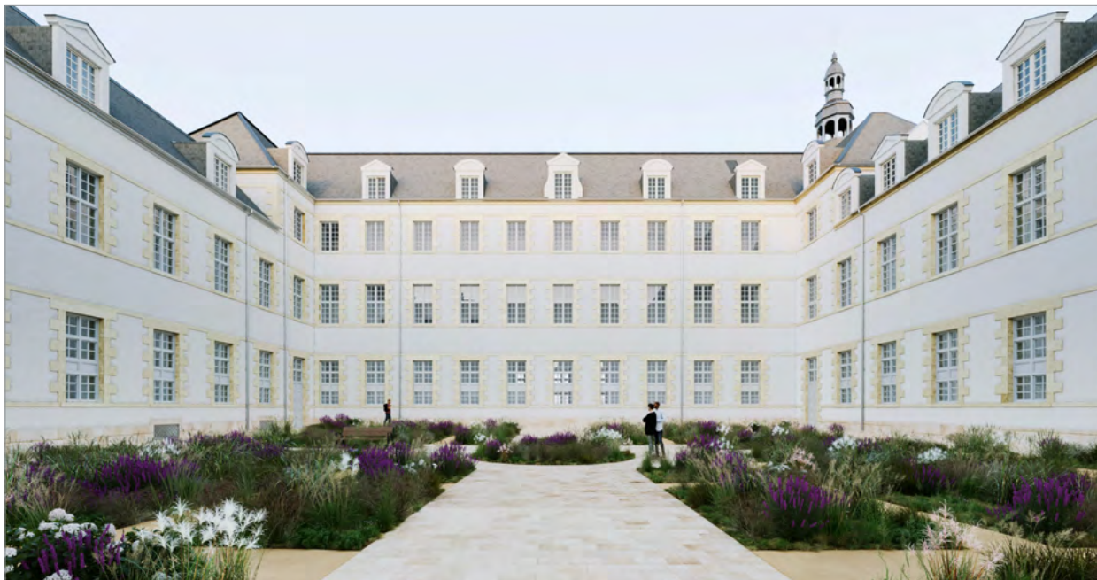
Figure 19 : Le campus Madeleine-Orléans après réhabilitation (45)
