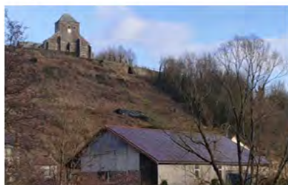
Panneaux bruns sur hangar, pan complet Dun-sur-Meuse (55)
