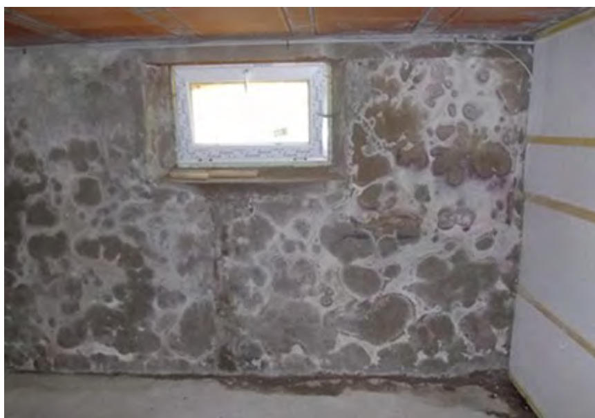
Figure 35 : Développement de micro-organismes à la suite de l'installation d'une menuiserie neuve dans une cave non ventilée. © Agence Qualité Construction
