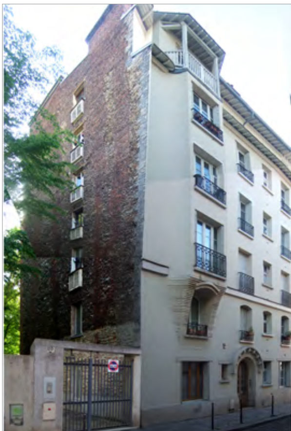
Figure 50 : Bâtiment de 1908 dont le mur pignon a été isolé thermiquement après concertation entre l'ABF et le maître d'ouvrage à Paris, en abord de monument historique (75)
