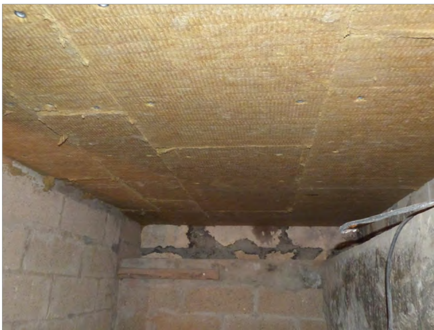
Figure 37 : Dans ce petit pavillon de 1925, le plancher bas sur vide sanitaire a pu être isolé en partie dans l'épaisseur à l'aide de panneaux de 12 cm de laine minérale insérés entre les solives. Une seconde couche croisée de 6 cm a été fixée par-dessous.
