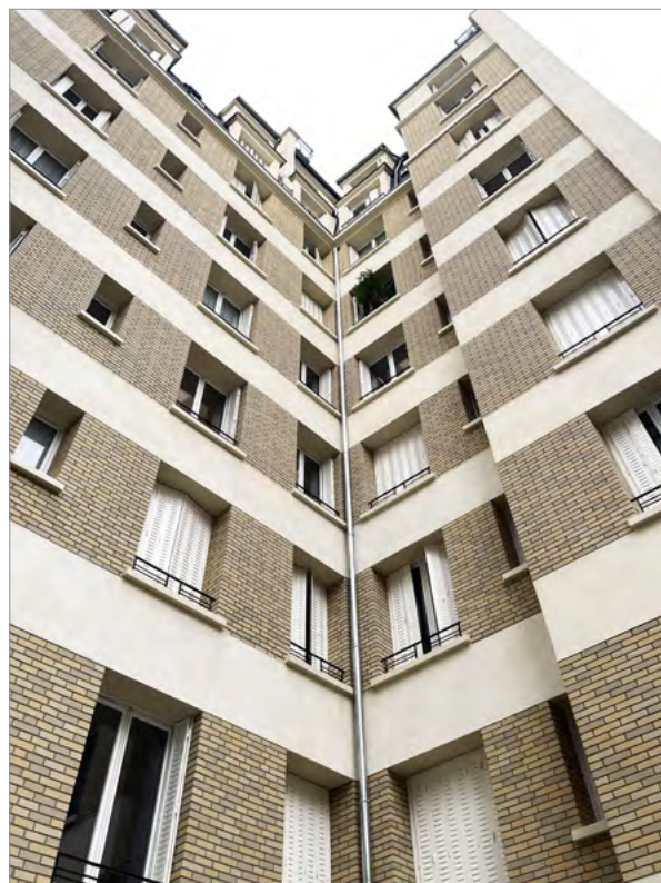
Figure 52 : Isolation par l'extérieur d'une façade sur cour à Paris (XIV e ), en abords de monument historique © Studaré
