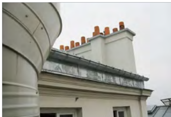
18 rue Caffarelli (Paris III e ) après le sarking : la gouttière et la corniche sont séparées par la sur-hauteur due à l'épaisseur de l'isolation. La sur-hauteur est habillée en zinc.
