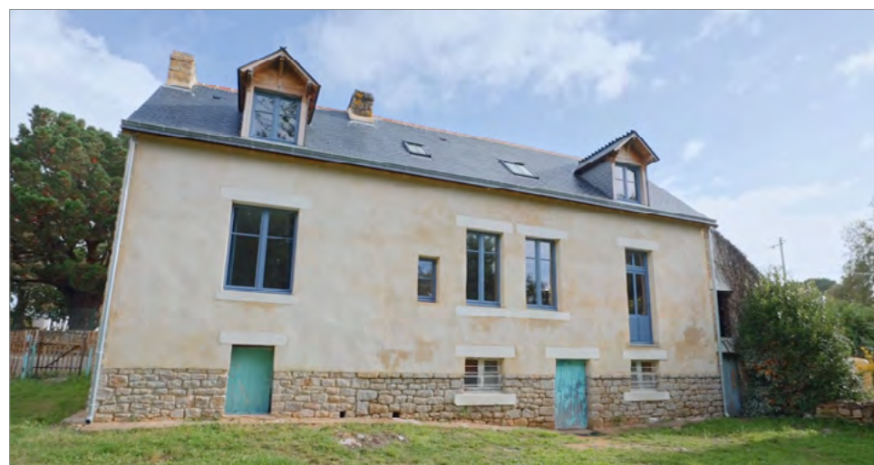
Figure 40 : Suppression de l'enduit ciment, séchage de la maçonnerie, pose d'un enduit traditionnel à la chaux (49).
