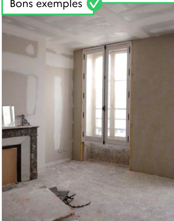
Figure 65 : Installation d'une double fenêtre dans un appartement à Bayonne (64) en site patrimonial remarquable.
