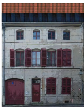
Figure 73 : Exemples d'intégration architecturale de panneaux solaires photovoltaïques © UDAPs du Grand Est
