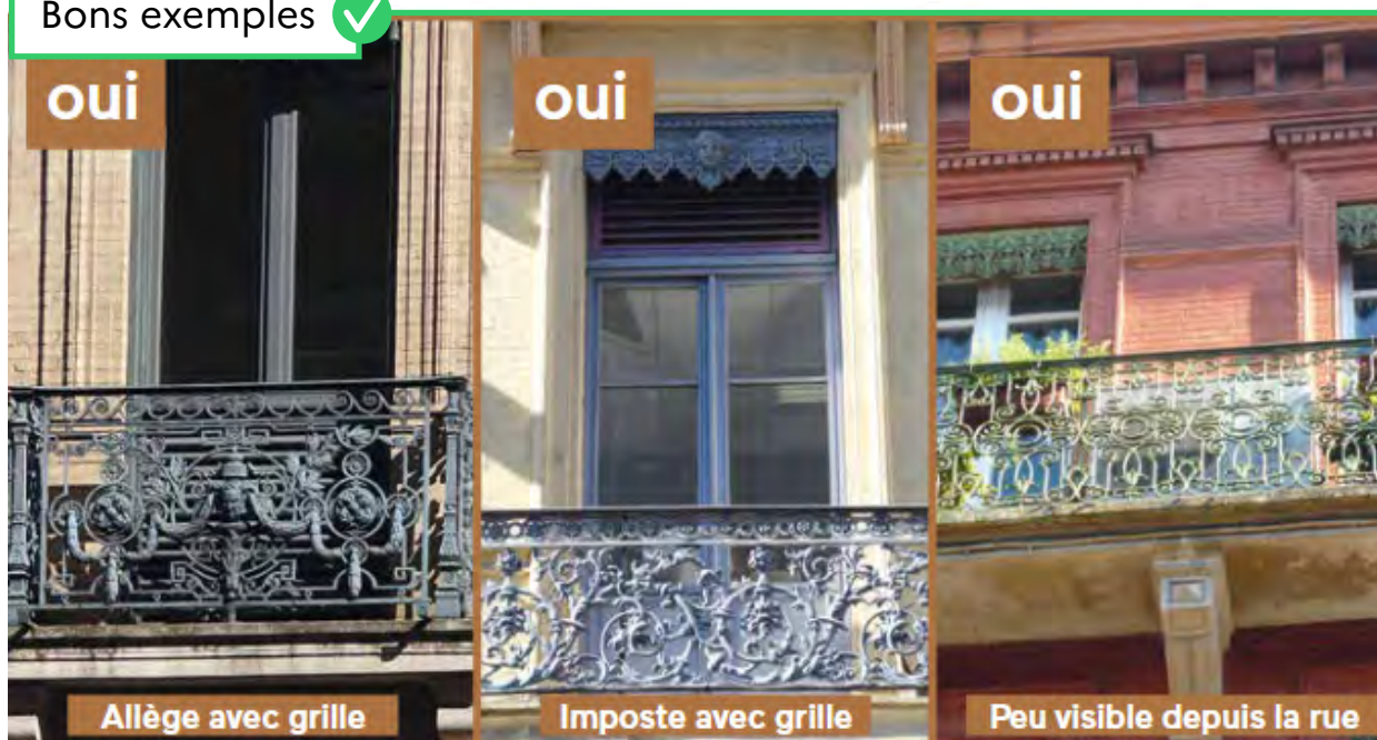
Figure 72 : Bons exemples d'intégration architecturale d'unités extérieures de PAC sur les balcons
