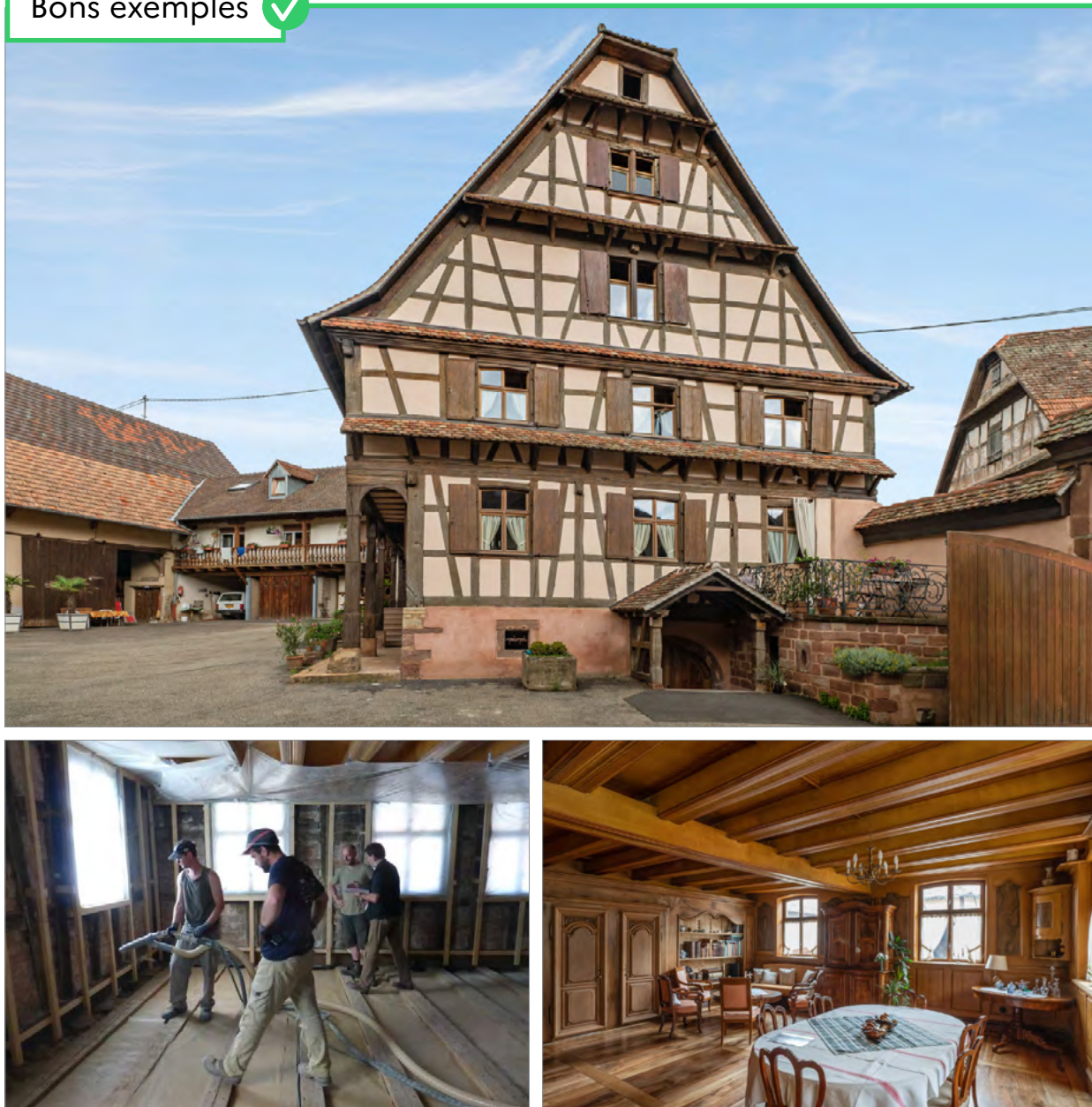
Figure 45 : Correction thermique par l'intérieur des murs en pains de bois à l'aide de 12 à 18 centimètres de béton de chanvre, puis repositionnement des boiseries (67). Cette réhabilitation a été labellisée par la Fondation du Patrimoine.
