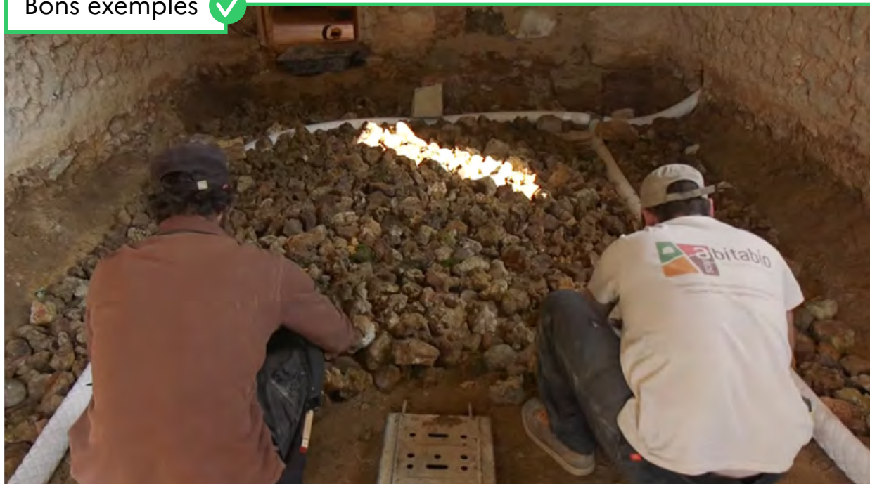
Figure 39 : Réalisation d'un hérisson de cailloux ventilé après décaissement du sol.
