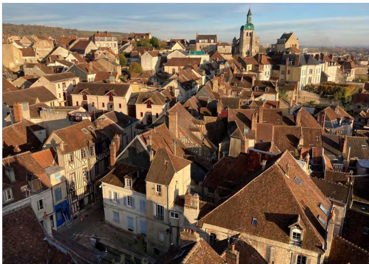
Figure 13 : La réglementation n'oblige pas à isoler par l'extérieur les façades du centre ancien de Joigny (89), car il s'agit de bâtiments construits avec des matériaux traditionnels (pan de bois, pierre).
