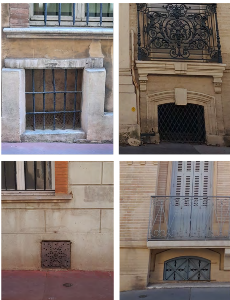
Figure 33 : Des soupiraux en bas d'immeubles à Toulouse (31)
