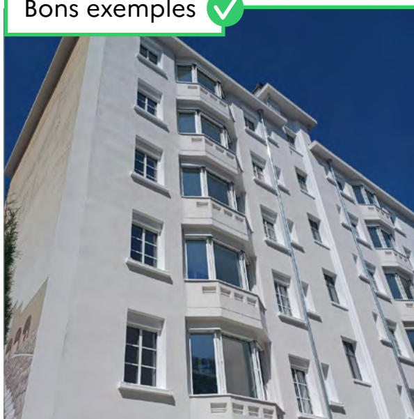
Figure 55 : Enduit isolant extérieur sur un immeuble de logement social dans le VIII e arrondissement de Lyon (69), en abords de monument historique.
