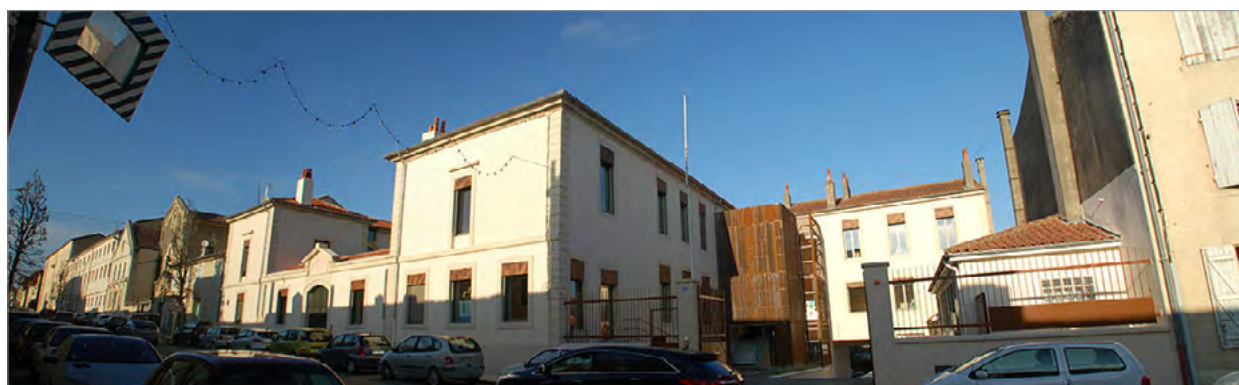
Figure 12 : Bâtiment patrimonial Pierre Verte à Auch
