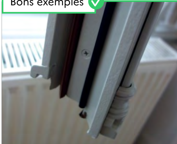
Figure 62 : Intégration de joints pour amélioration des performances techniques (69) © RL&Associés
