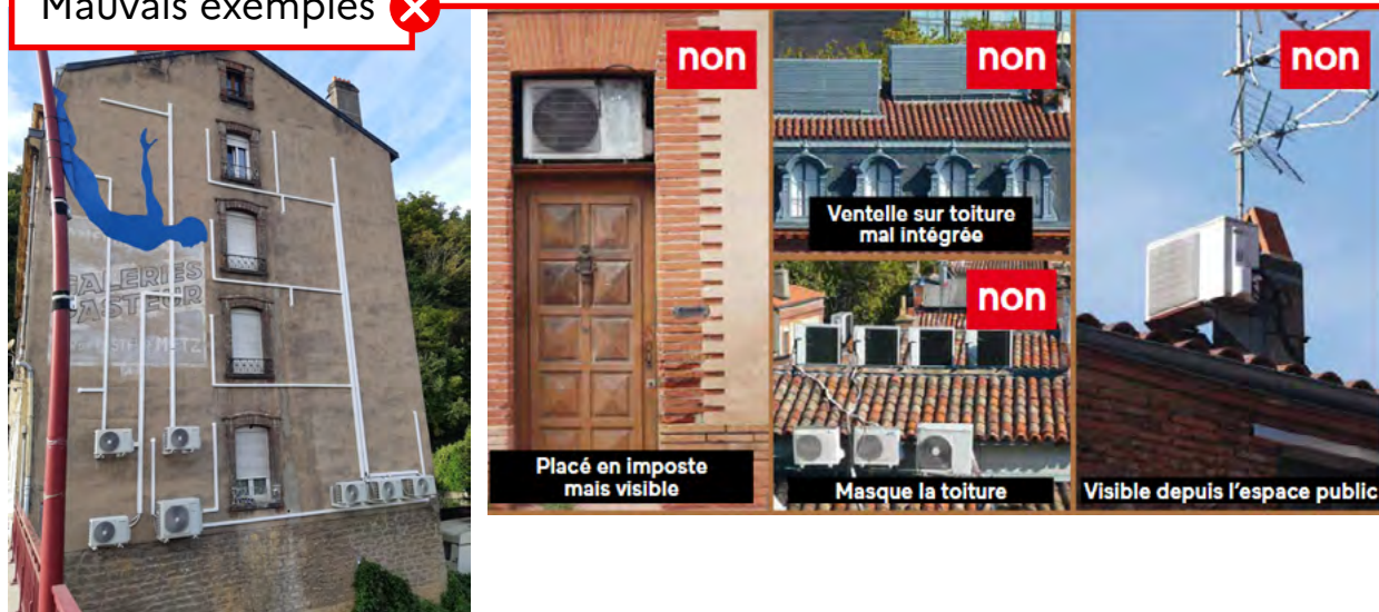
Figure 71 : Les unités extérieures des PAC de ces immeubles ont été installées sans grande considération pour leur intérêt patrimonial (54 et 31).
