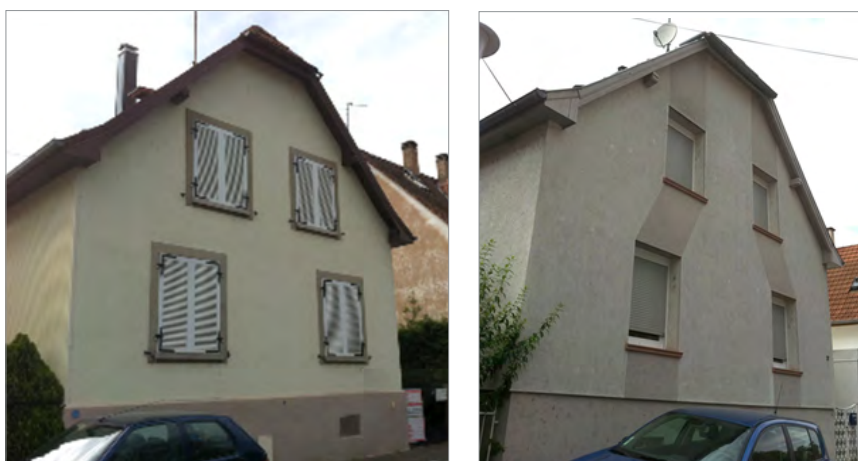
Figure 48 : La mise en œuvre d'une isolation par l'extérieur des murs, le changement des fenêtres et la suppression des volets ont totalement modifié l'aspect de cette maison (67).
