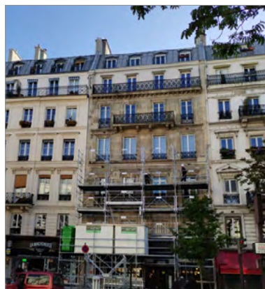
Figure 56 : Les deux étages d'attique de ce bâtiment situé en site inscrit, en zone tampon UNESCO et en abord de monument historique ont été corrigés thermiquement par l'extérieur avec 8 cm d'un enduit isolant
