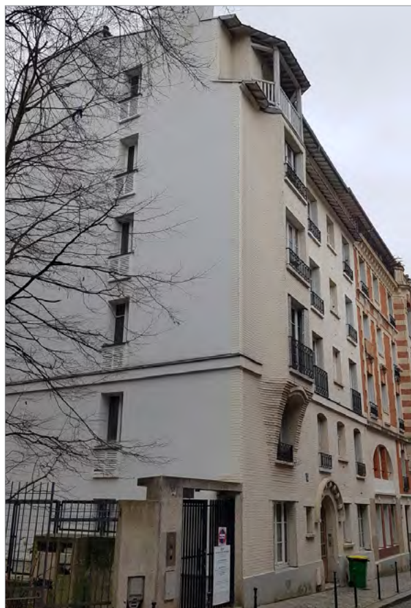
Figure 50 : Bâtiment de 1908 dont le mur pignon a été isolé thermiquement après concertation entre l'ABF et le maître d'ouvrage à Paris, en abord de monument historique (75)
