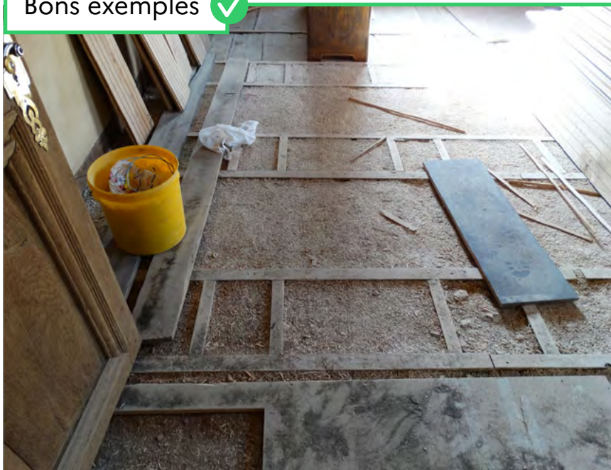
Figure 36 : L'ensemble du remplissage existant (gravas, sable, plâtre) entre solives a été cureté. Un isolant à base de fibres végétales a été mis en œuvre en remplacement afin de répondre aux besoins thermiques et acoustiques.
