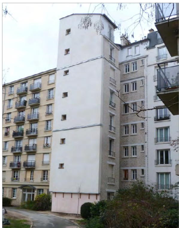
Figure 51 : Isolation par l'extérieur en paille d'une façade sur cour à Paris (XV e ), en abords de monument historique
