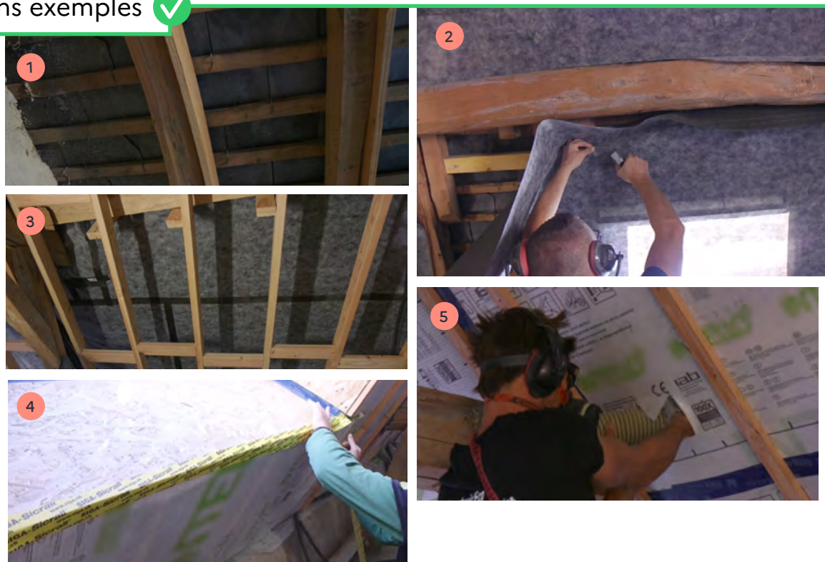
Figure 26 : Les différentes étapes de la réalisation d'une isolation par l'intérieur sous chevrons par insufflation de ouate de cellulose : (2) mise en place d'un pare-pluie sous les tuiles (3) mise en place d'une ossature bois légère (4) pose de la membrane gérant l'apport de vapeur sur l'ossature (5) insufflation de la ouate dans le caisson
