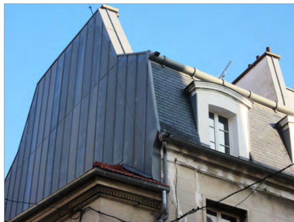
Figure 53 : À l'occasion de la reprise complète de la toiture, l'ABF a accepté le projet d'isolation par l'extérieur de l'héberge. Les panneaux de laine de bois ont été protégés par un bardage zinc réalisé à l'ancienne. Saint-Denis (93).
