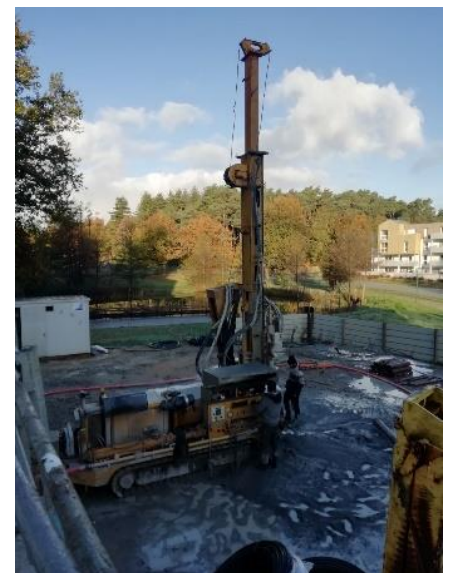
Forage pour sonde verticale
